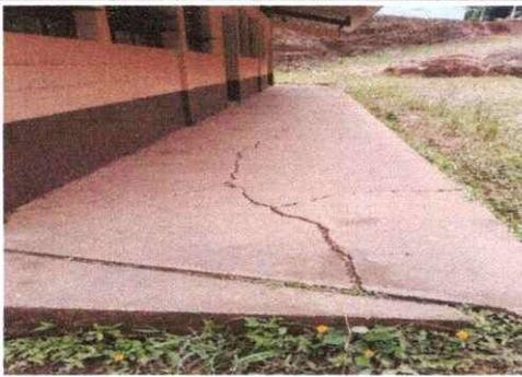
Foto 3: Se observa el piso del corredor que esta quebradas y necesita reparalo .
