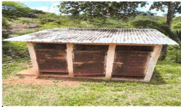
Foto 6: Se observa el modulo 2 que necesita pintarla y cambio de techo.
