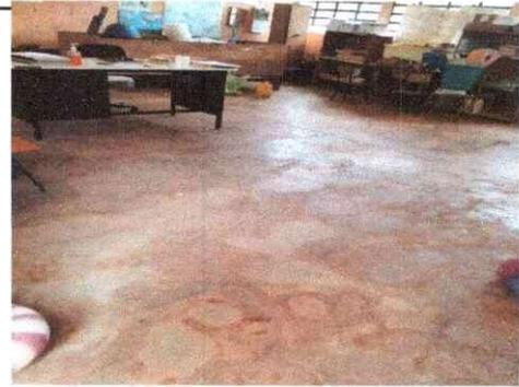
Foto 4: Se observa el piso de las aulas en deterioro.
